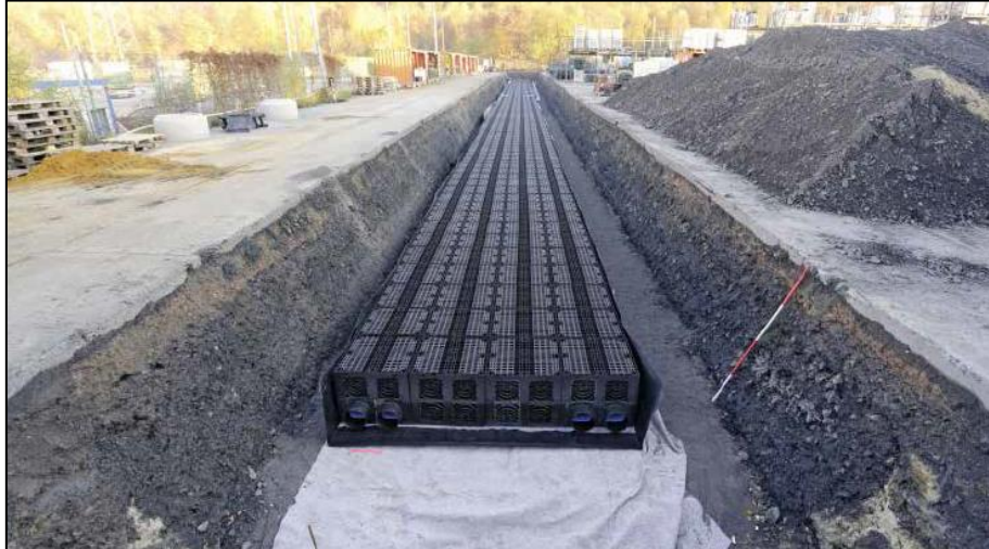
Abbildung 13: Ausführung einer Rigole mit Kunststofffüllkörper der Fa. Rehau [Quelle: Fa. Rehau, 2016]
